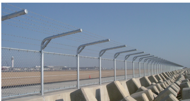
セントレア外周フェンス。テロ対策侵入防止目的で施工
